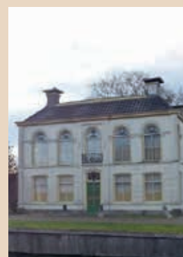
Directeurswoning Houtzagerij, Gorredijk
