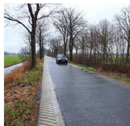
Berm beton en klinkerverharding in de berm aan de Slúswei.
