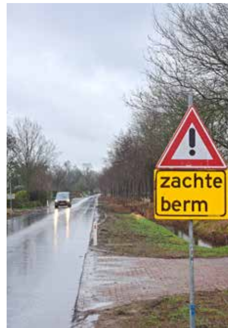
Een deel van de Binnenwei is vorig jaar voorzien van nieuw asfalt. Over enige tijd ontstaat kleurt de weg in het midden lichtgrijs en zijn de zijkantenzwart, waardoor weggebruikers een optische wegversmalling waarnemen. De berm is door de werkzaamheden op dit moment nog zacht.
