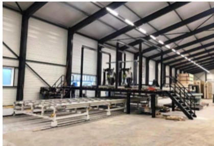
Pre-fab bouw IIBO
