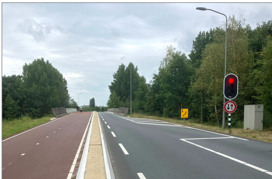
Figuur 6-12: Referentiebeeld wegversmalling met voorrangsregeling en verkeersregelininstallatie ter hoogte van het viaduct over de A12 tussen Veenendaal en Ede
