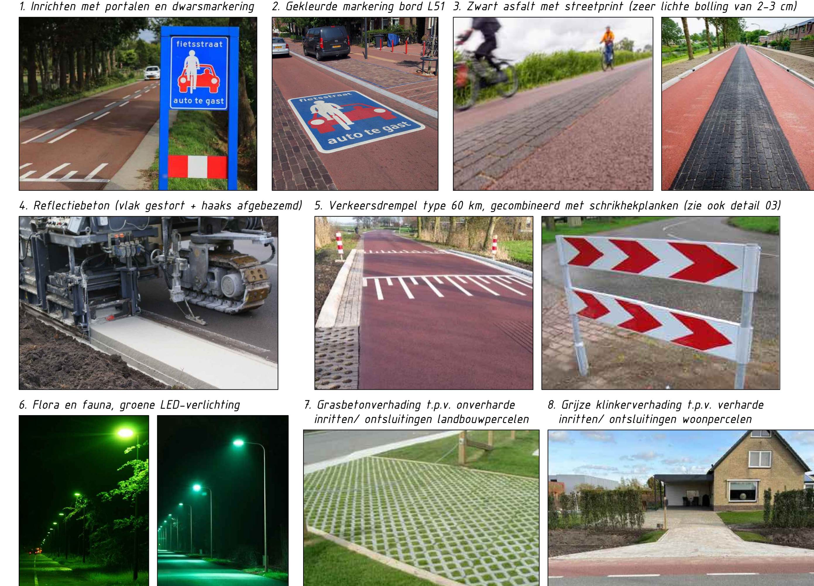
DETAIL 02: Verkeersdrempel type 60 km (h=0,12m) SCHAAL 1:50
