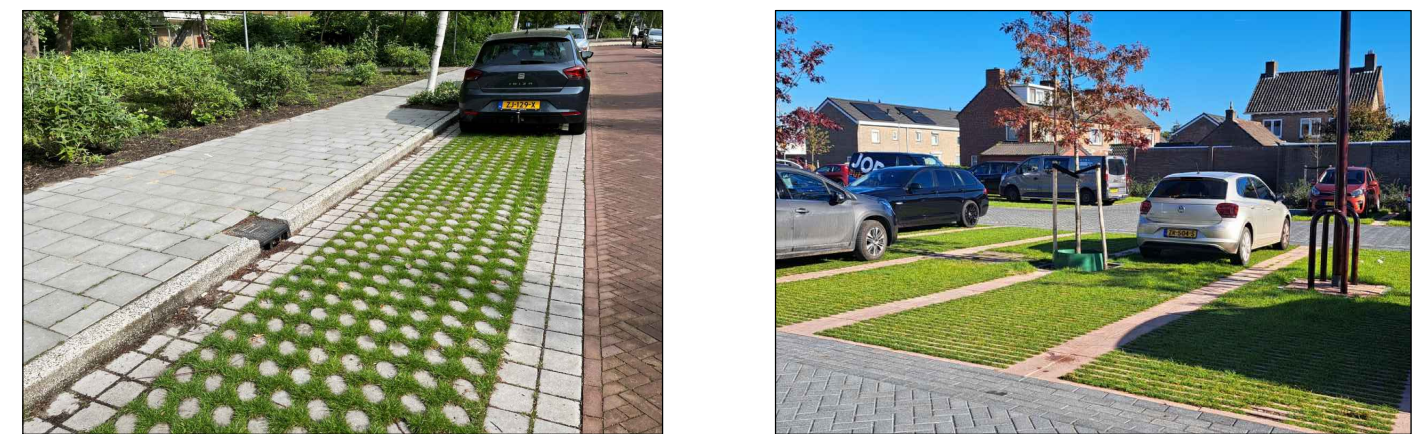
2. Grasbetonverharding t.p.v. parkeervakken 30 km/uur zone
