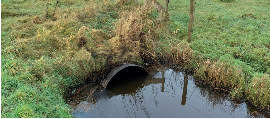
Een duiker is een vaak kokervormige waterdoorgang, gelegen in een weg of dam.
