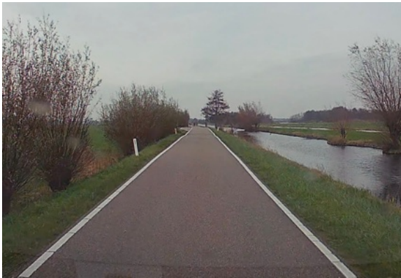
Afb. 9: Beschikbare ruimte met duidelijke kantmarkering
