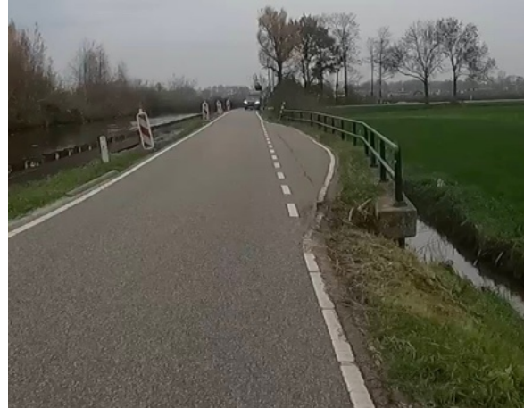
Afbeelding 4: Voorbeeld gevaarlijke berm voor fietsers
