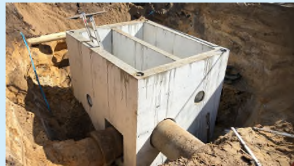
Foto: Aanleg riolering en putten (Marialaan – Reusel)
