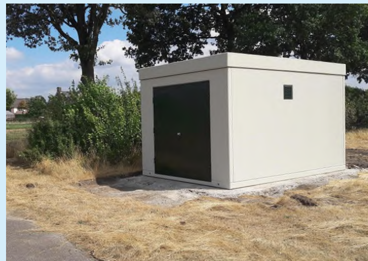
Foto: Vacuümstation (Zeegstraat – Reusel)
