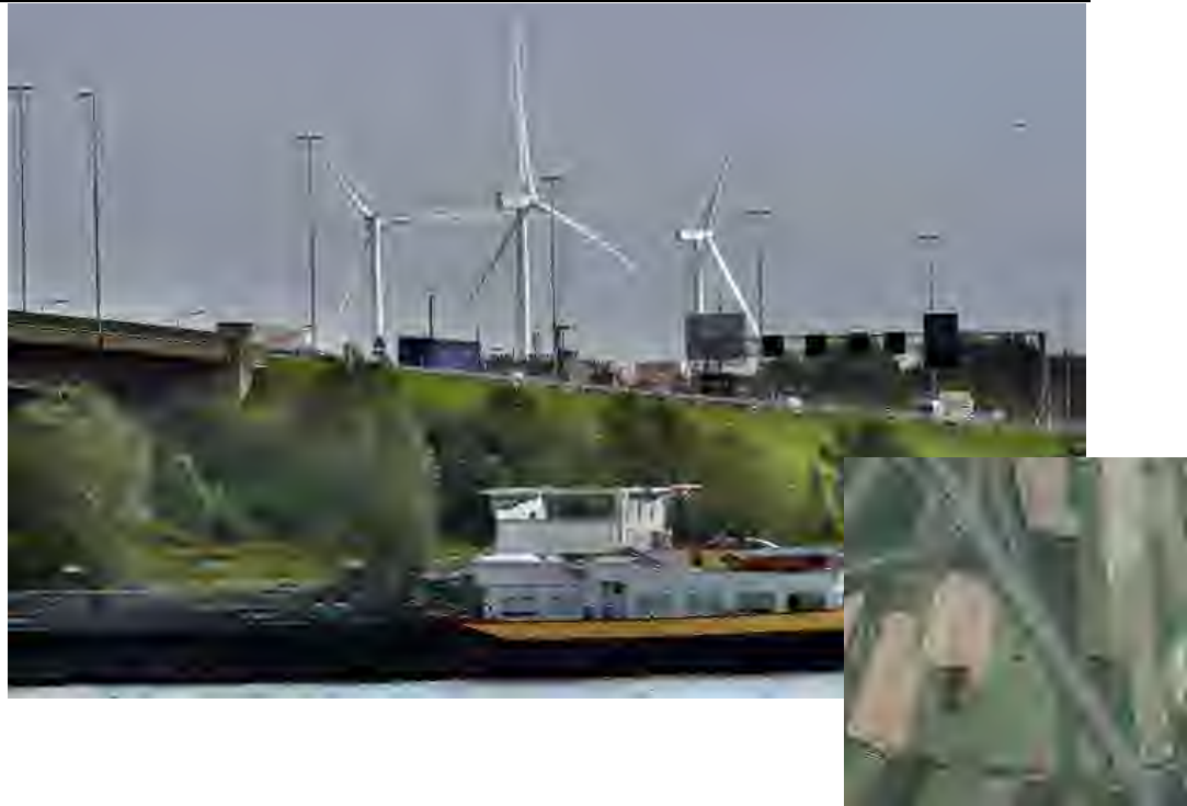
Figuur 18 Voorbeeld van een lijnopstelling met een lichte kink die vanuit bepaalde hoeken niet als zodanig waarneembaar is. (Windpark Autena Vianen, gemeente Vijfheerenlanden).
