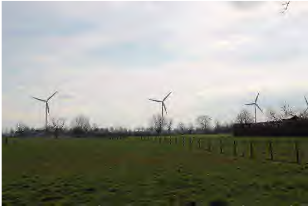
Figuur 22 Windpark op een afstand van ca. 10 keer de tiphoogte: de windturbines zijn goed zichtbaar.
