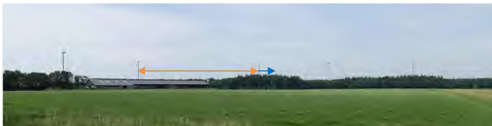
Figuur 4.7 Windpark Agro-Wind, van standpunt 3 (met De Pals op de achtergrond)
