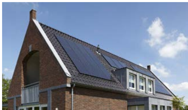
Zonnepanelen liggen op afstand van de dakrand
