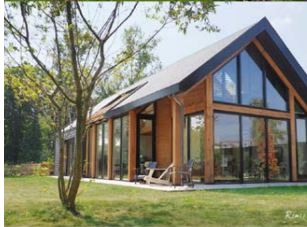
Bebouwing komt niet boven de boomkruinen uit
