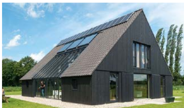
Zonnepanelen volgen de dakhelling
