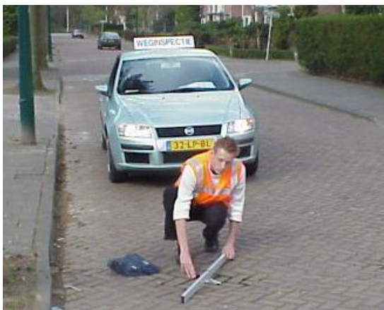
Figuur 4 Beoordelen schade tijdens globale visuele inspectie
