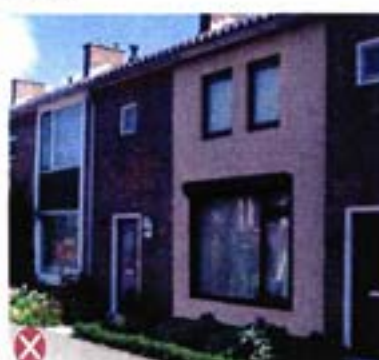
fig. 10 nog meer verstoring door afwijkend materiaal voor kozijnen en gevelvlak
