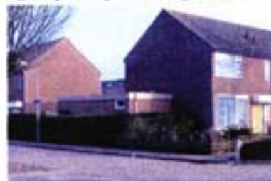
fig. 4 goed geplaatst, passende vormge- ving en materiaaltoepassing
