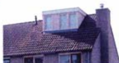
fig. 12 te hoog op het dak, profiel van de woning wordt aangetast
