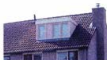
fig. 15 evenwichtig van plaatsing.
