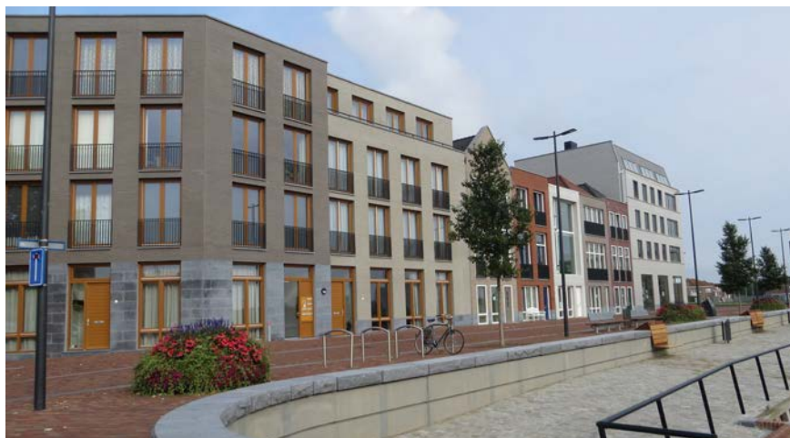
Referentie: bestaande inrichting van de Peperdijk
