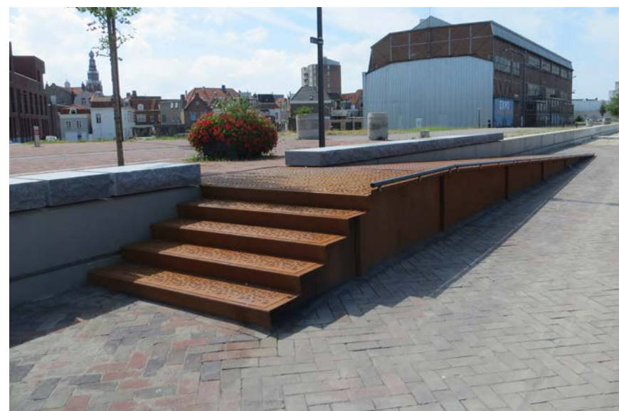
Bestaande eigentijdse cortenstalen inrichtingselementen rondom het Dok
