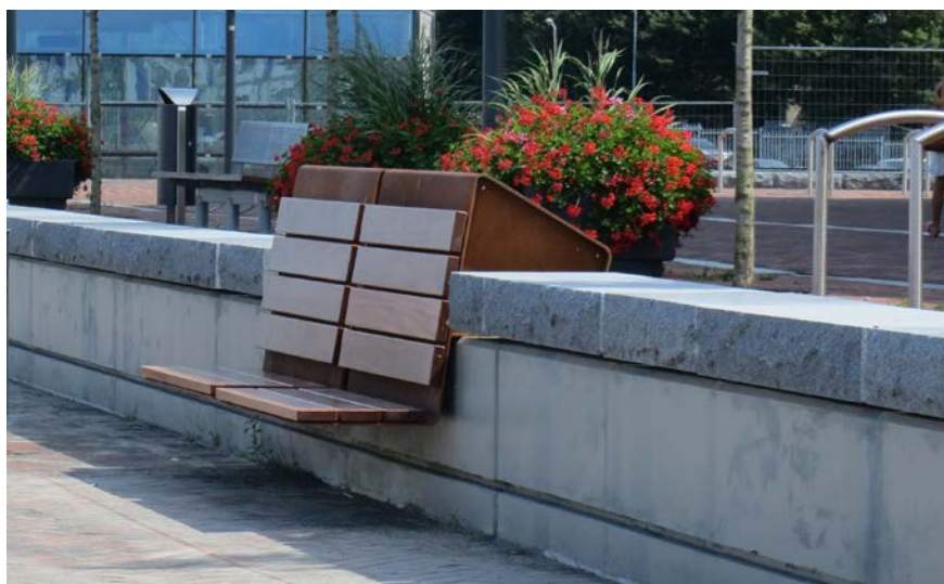
Bestaande keermuur, met eigentijds vormgegeven zitelementen
