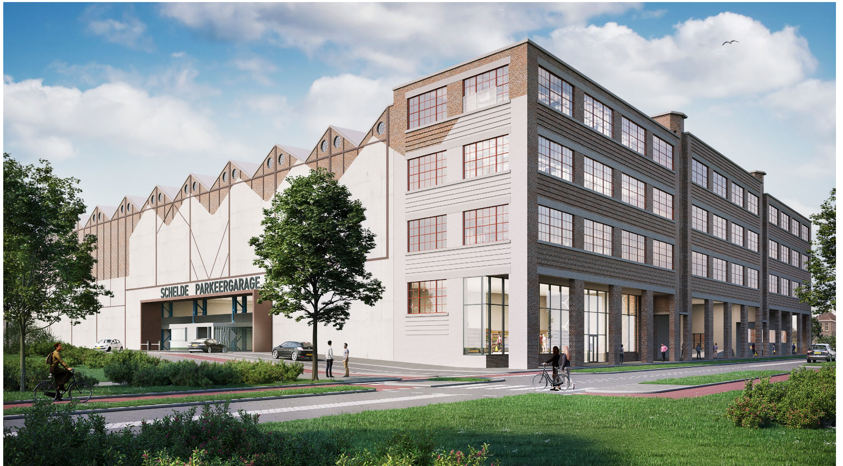
Oostzijde met entree parkeergarage
