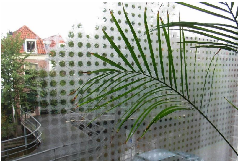
Figuur 4. Zichtbaar effect bij condens aan de buitenzijde op vacuümglas (Bron: Kees van der Linden, AaCee Bouwen & Milieu)
