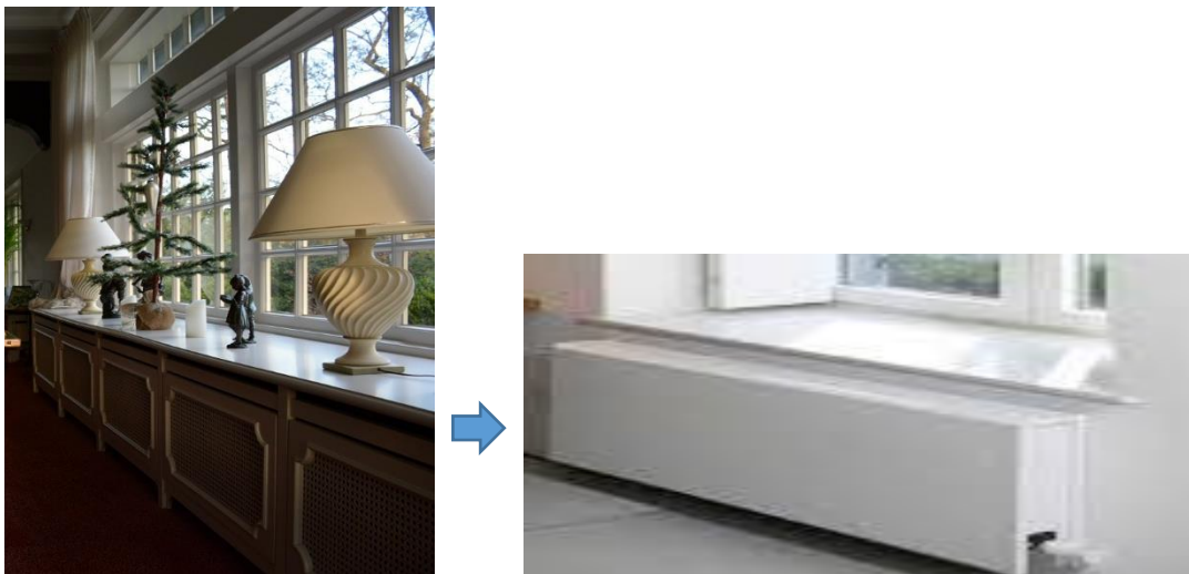
Figuur 11. Radiatoren achter omkasting vervangen voor LT-convector als vloerverwarming alleen als basisverwarming inzetbaar is bij te hoge warmteweerstand vloerafwerking.
