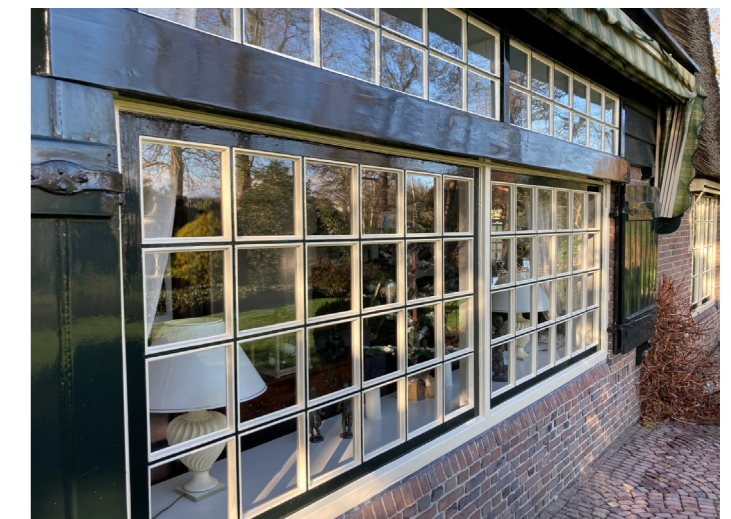
het bestaande grote kozijn aan de voorzijde (merk A)
