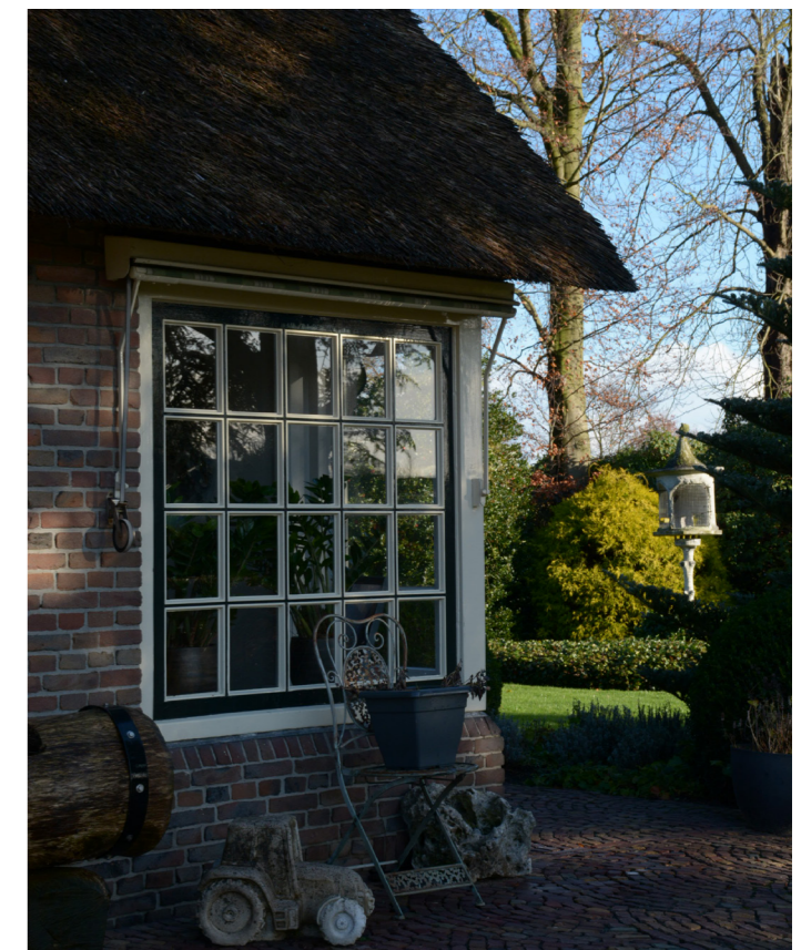
het bestaande hoekkozijn aan de voorzijde (merk S)
