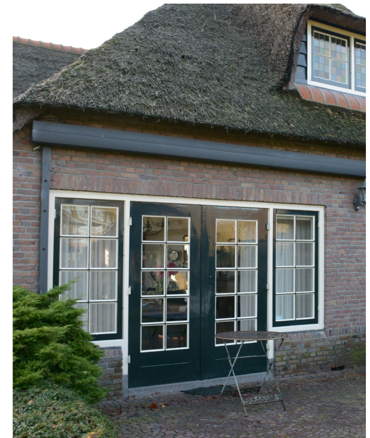
het bestaande kozijn met terrasdeuren (merk C)
