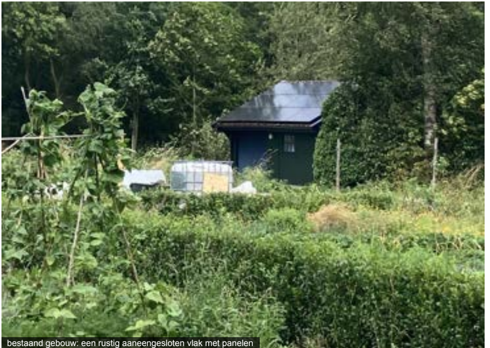
bestaand gebouw: een rustig aaneengesloten vlak met panelen
