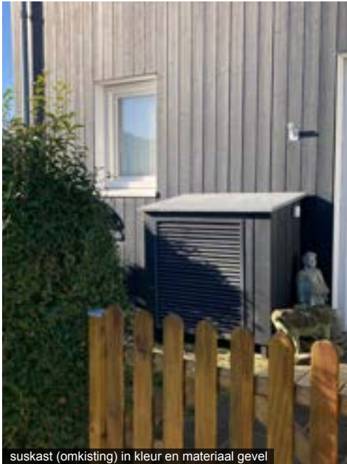
suskast (omkisting) in kleur en materiaal gevel
