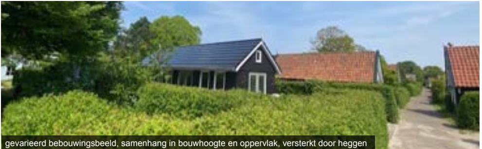
gevarieerd bebouwingsbeeld, samenhang in bouwhoogte en oppervlak, versterkt door heggen
