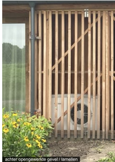
achter opengewerkte gevel / lamellen
