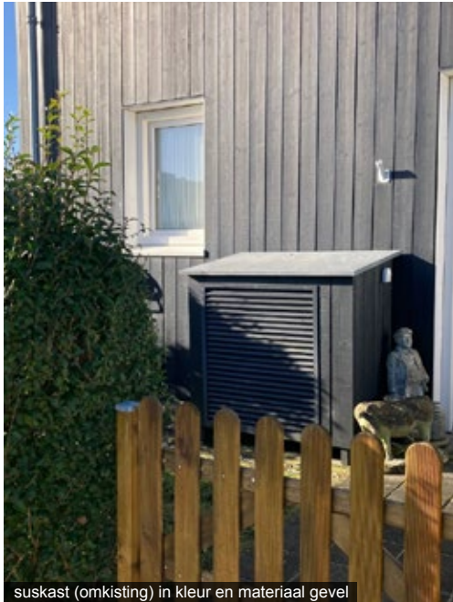
suskast (omkisting) in kleur en materiaal gevel
