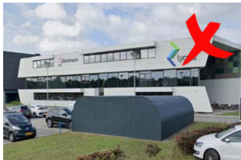
Reclame uitingen maximaal één maal per gevel
