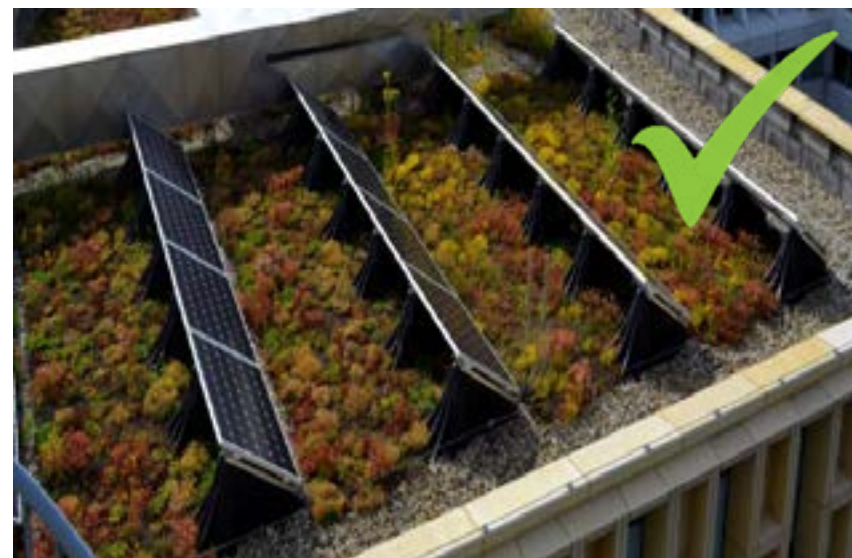
Zonnepanelen dragen bij aan een duurzamer bedrijf
