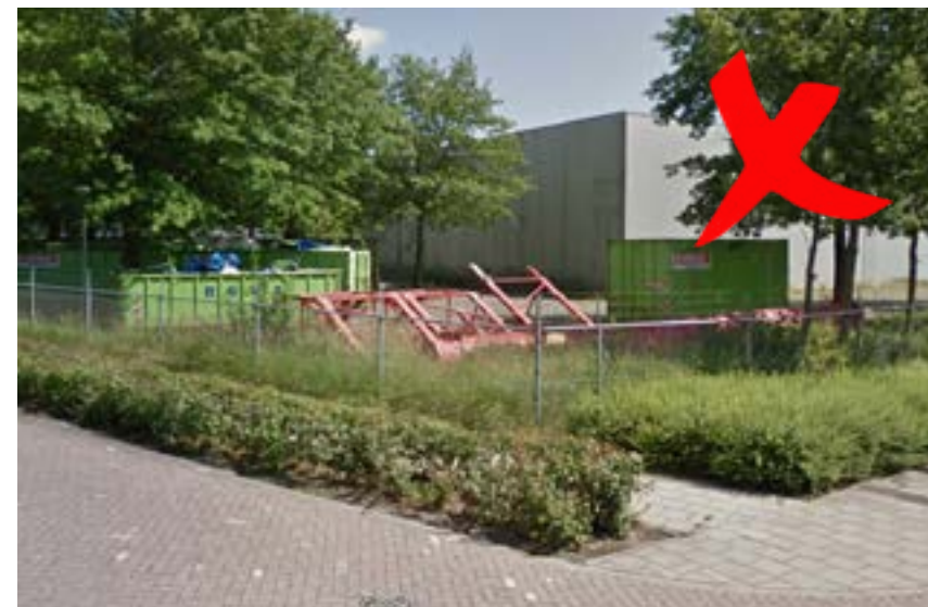
Staalmathekwerk alleen toegestaan op erfgrenzen die niet grenzen aan de openbare ruimte.
