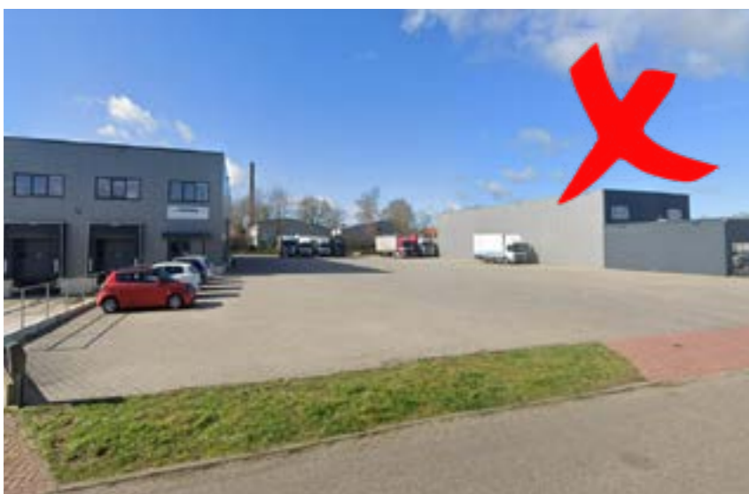
Probeer zo min mogelijk te verharden dus niet van gevel tot gevel dicht straten
