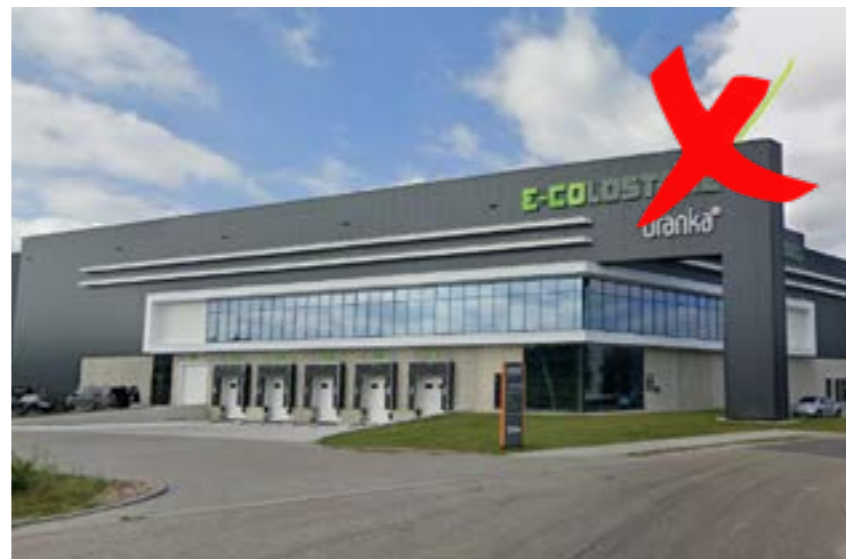
Laad- en losserrons niet aan de voorgevel zijn niet toegestaan
