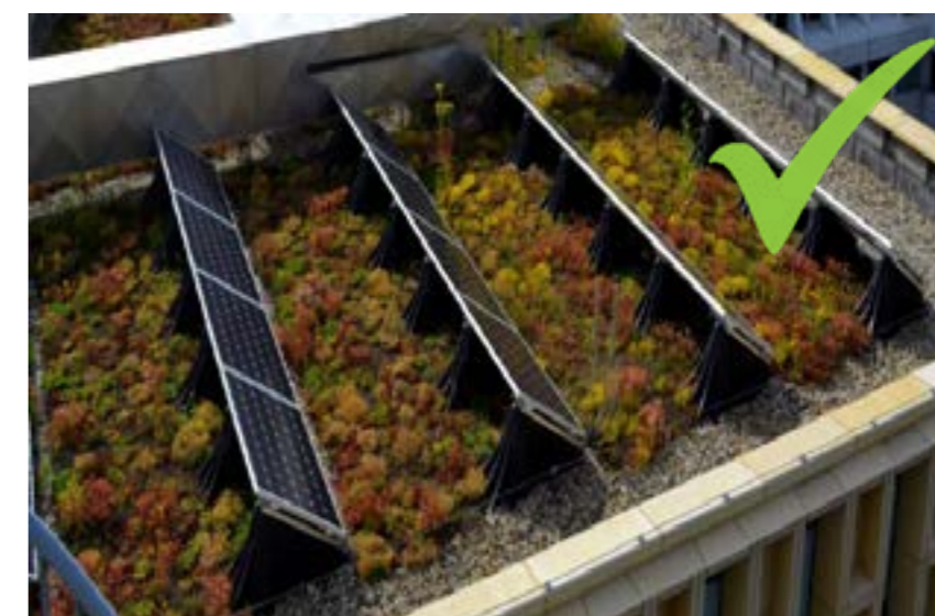
Zonnepanelen dragen bij aan een duurzamer bedrijf
