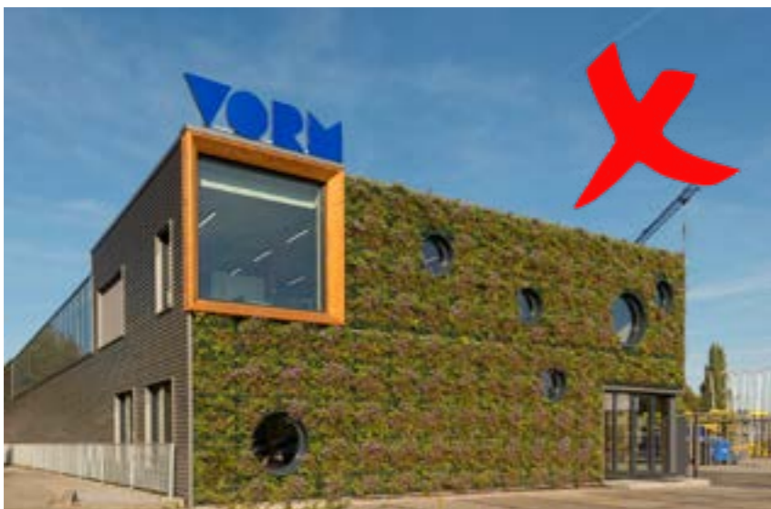
geen reclame uitingen boven dakrand
