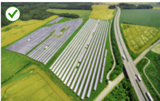
De transformatoren logisch plaatsen in het zonnenveld...
