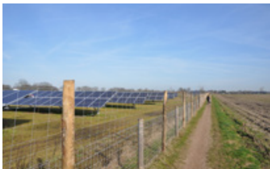
Plaats het hekwerk dicht op de panelen
