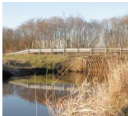
Grootschalige infrastructuur: de Reest wordt abrupt doorsneden door de snelweg A 28
