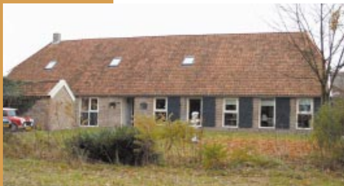
Gevelindeling: deze tot kantoor verbouwde boerderij in IJhorst heeft teveel openingen op een rij.
