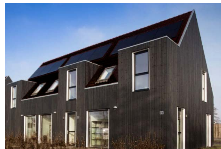
Voorbeeld rijwoningen met een lage gootlijn waarbij aan de straatzijde verspringende gootlijnen zijn toegepast. Er is tevens sprake van een verticale geleding om de kleine korrel te benadrukken. Bron: Stelt-zuid.nl
