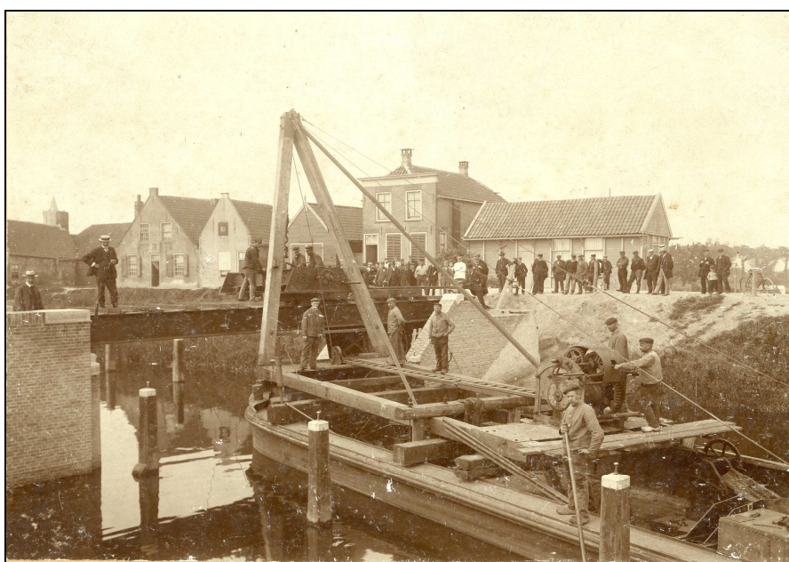
Aanleg brug over de haven van Dirksland
