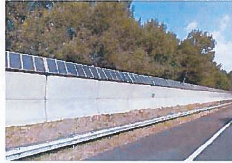
Geluidsscherm met zonnepanelen
