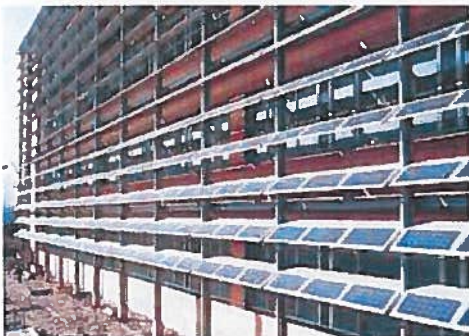
Zonnepanelen aan een gevel
