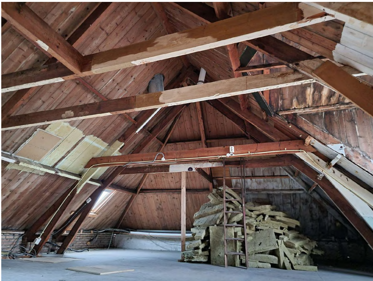
Achterste dwarsbalk is bewerkt en wordt ondersteunt door houten paal.
