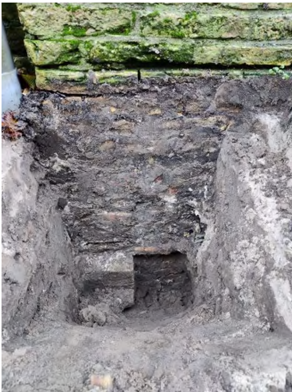
Onderzoek fundering linkerzijgevel tpv overgang aanbouw
