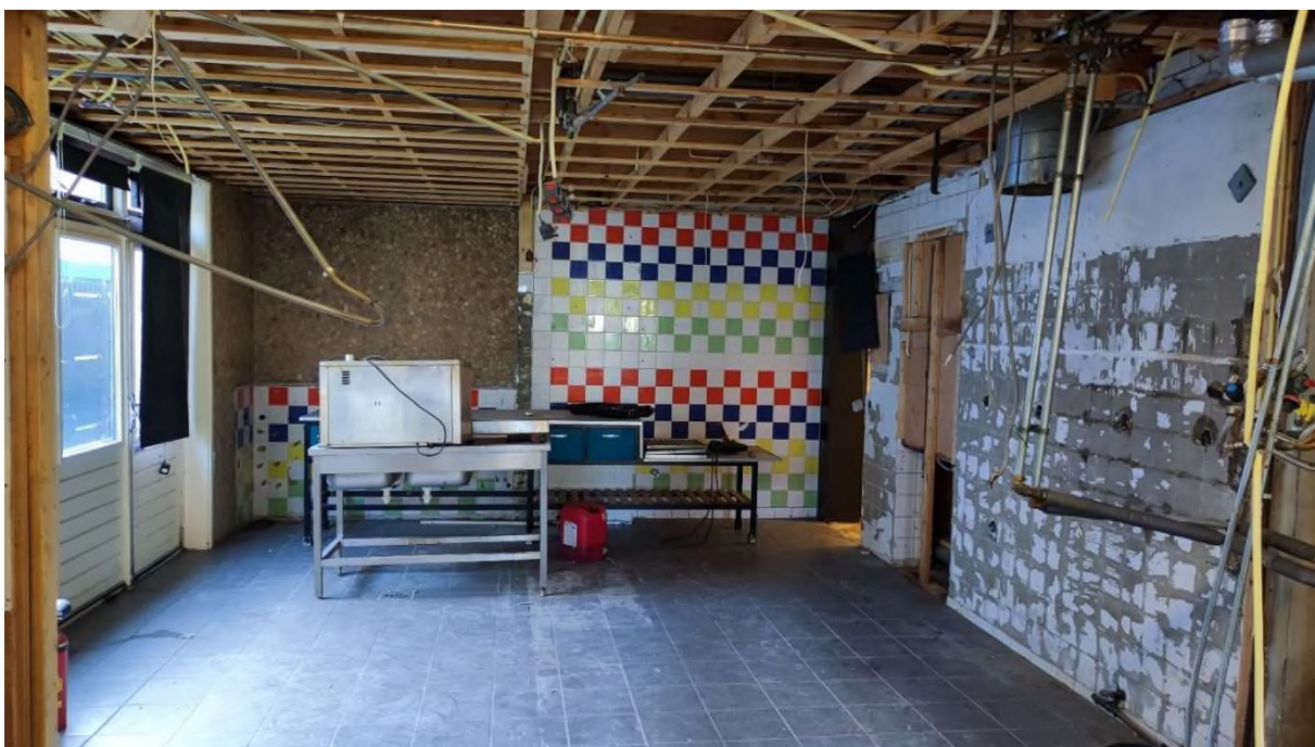
Aanzicht achtergevel aanbouw
