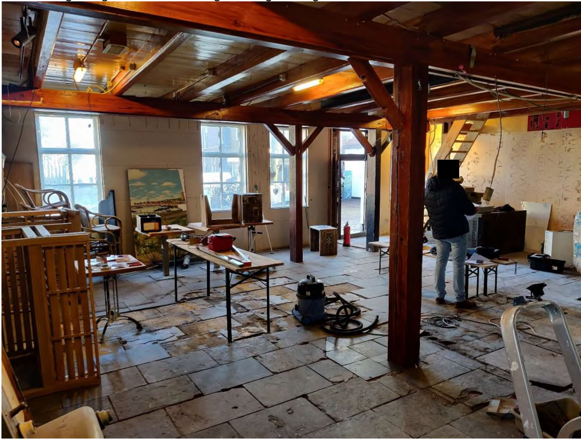
Foto richting achter. Ondersteuning balklaag niet orgineel
