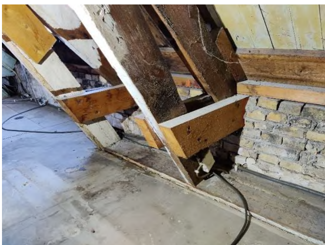
Vernieuwde blokkelen tpv voorgevel
