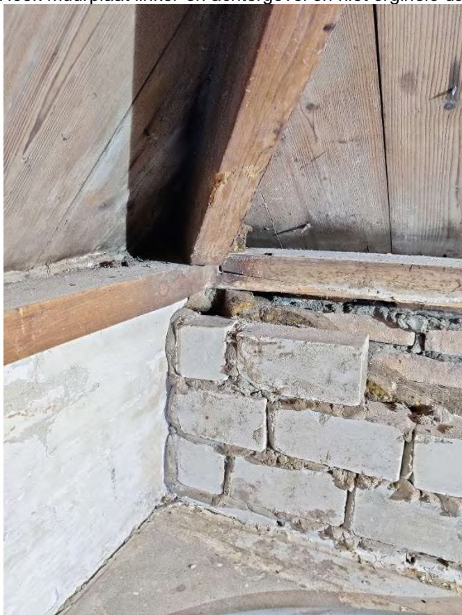
Hoek muurplaat linker-en achtergevel en niet originele dakramen in achtergevel
