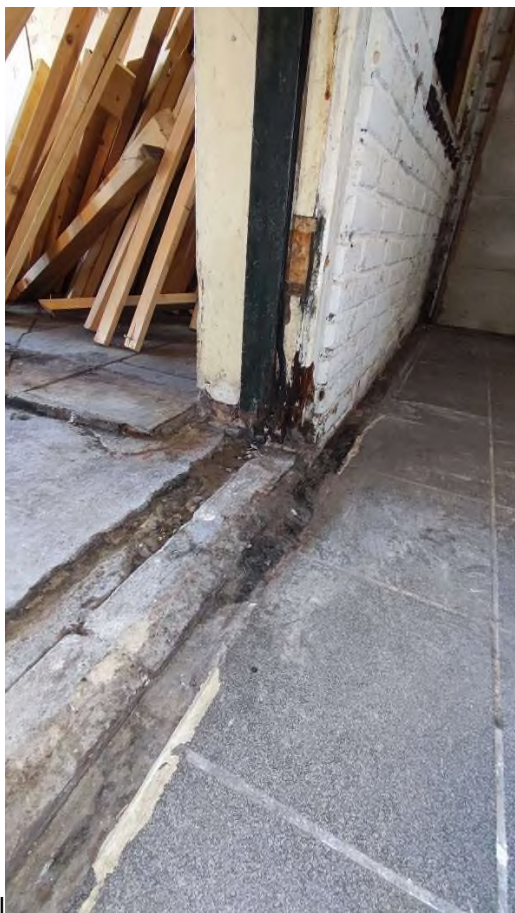
Fragment kozijn in achtergevel
