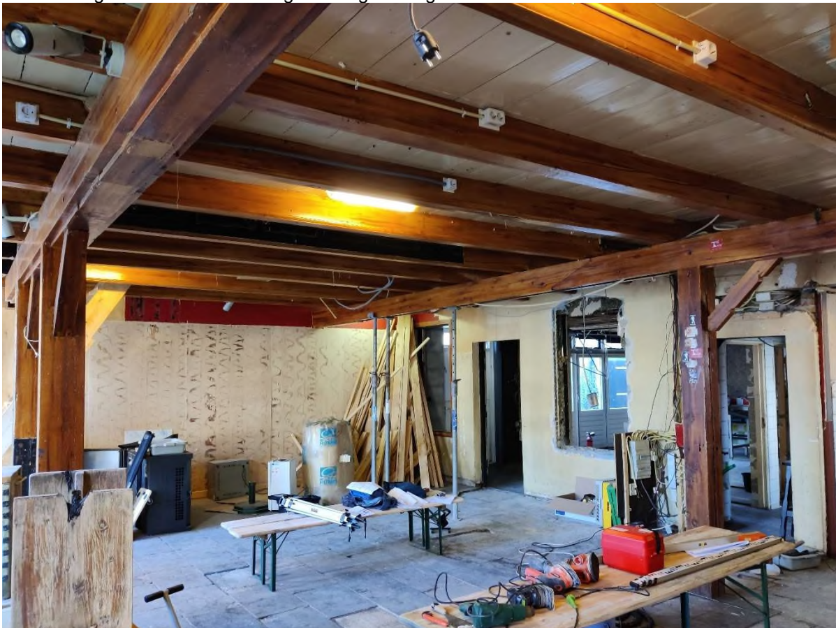
Foto richting achter. Ondersteuning balklaag niet orgineel
