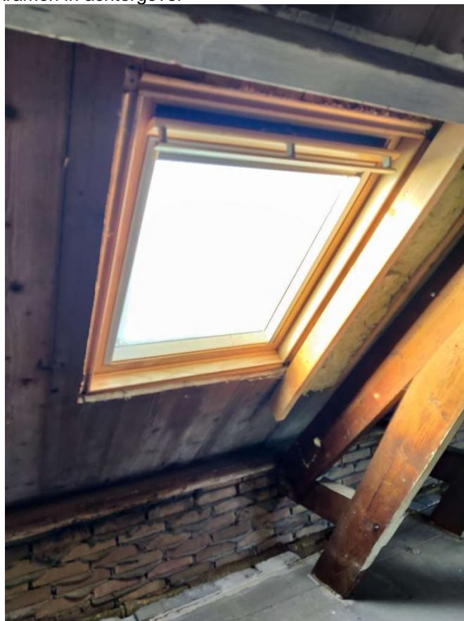
Hoek muurplaat linker-en achtergevel en niet originele dakramen in achtergevel
