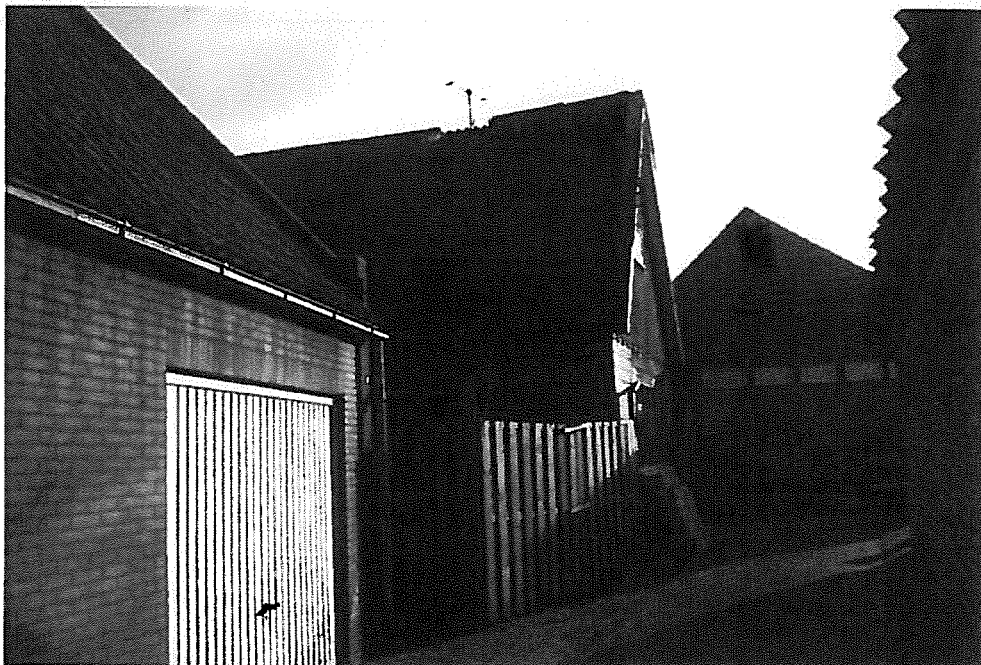
Foto 3: Bestaande schuur gezien vanaf de steeg.
