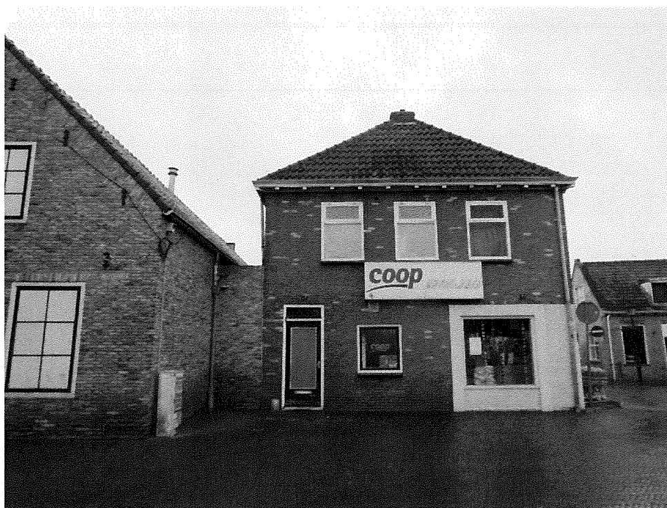
2. Voorgevel van Oosterburen 2.
