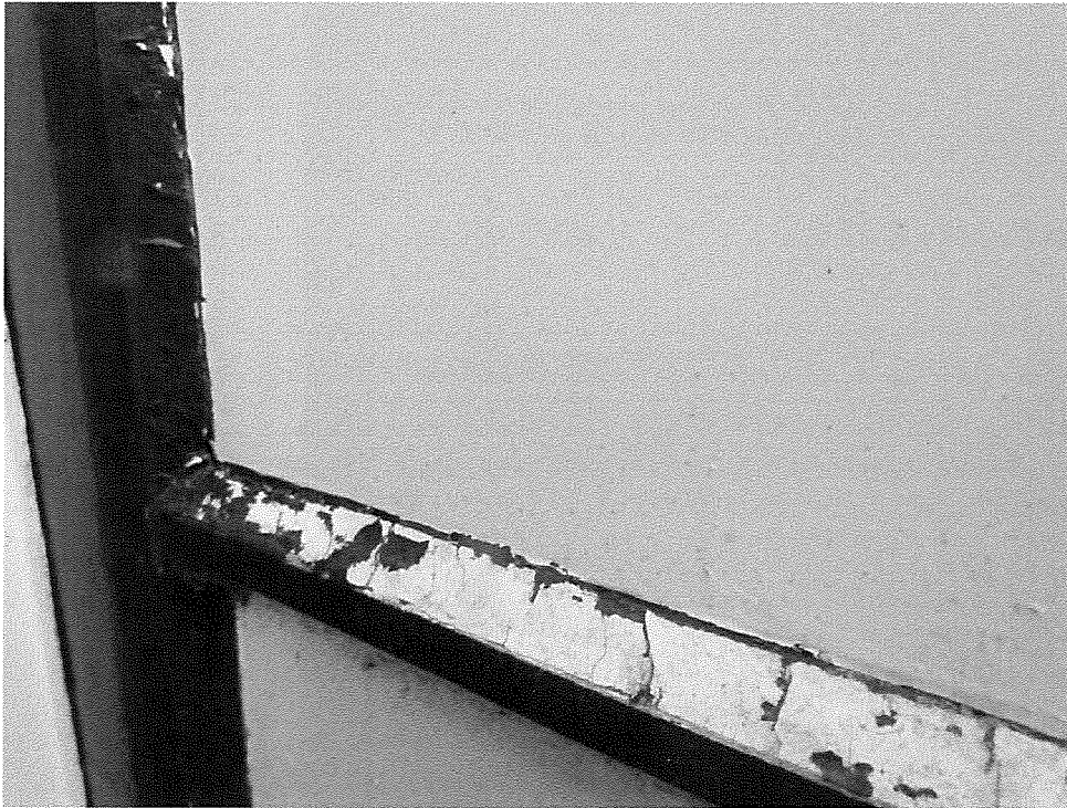
9. Ramen gevuld met een harde kunststof plaat, afgewerkt met stopverf.
