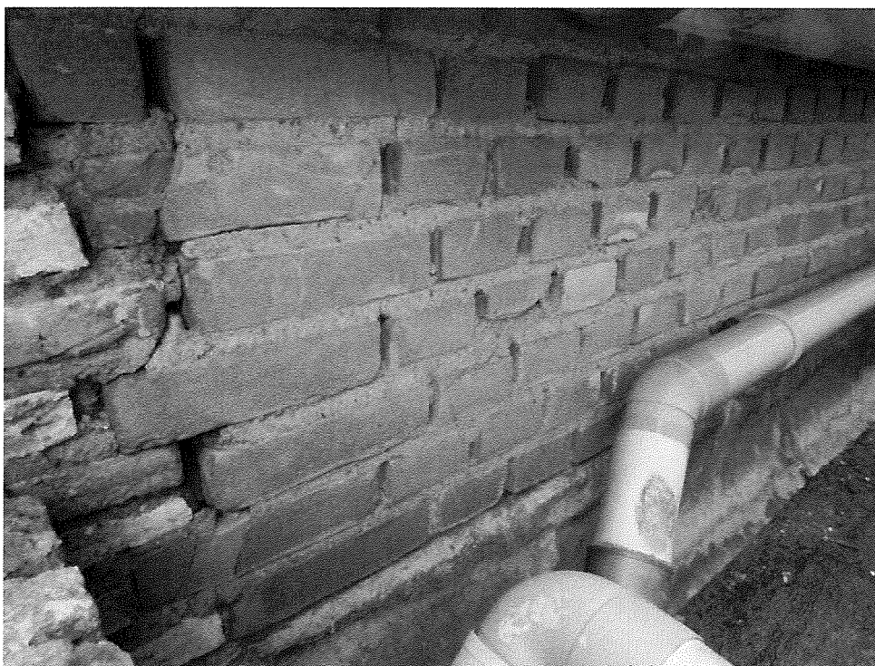
13. Overgang van halfsteens- naar koppenverband t.p.v. Oosterburen 2 en 4
