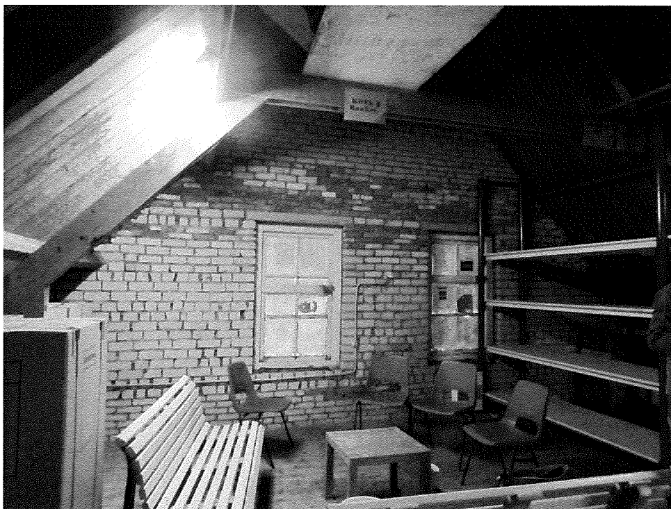
6. De binnenzijde van de voorgevel van nummer 4.
