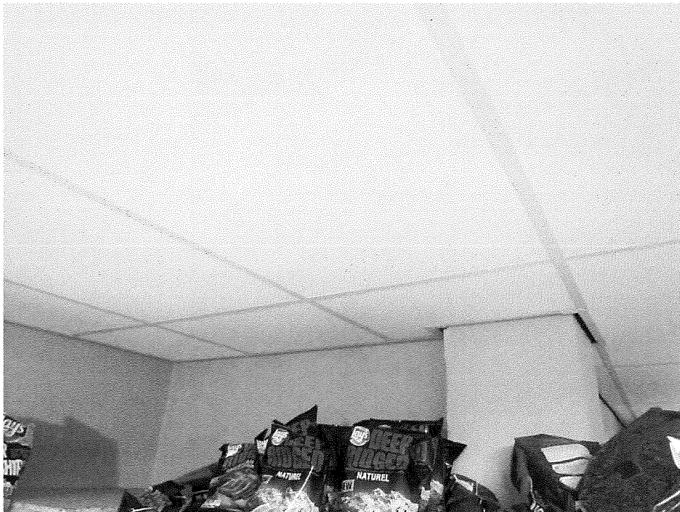
16. Afwerking plafond met een systeemplafond.
