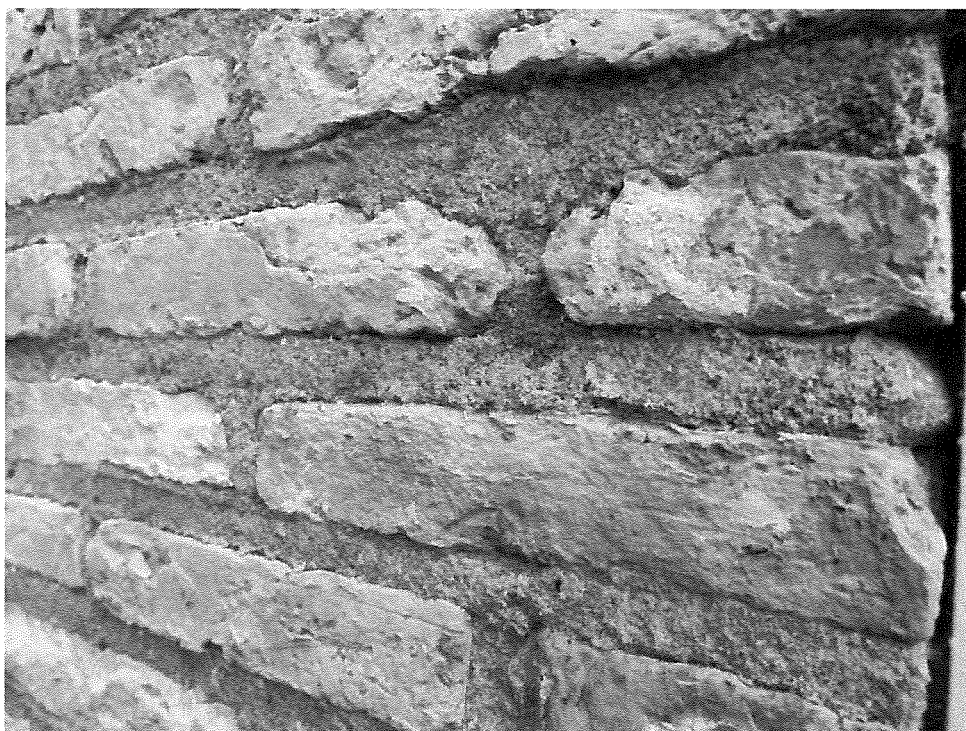
7. Metselwerk uitgevoerd met portlandcement.
