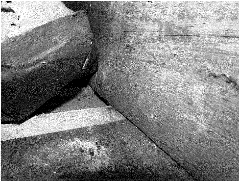
15. Balklaag met daaronder de (onbehandelde) staalconstructie.
