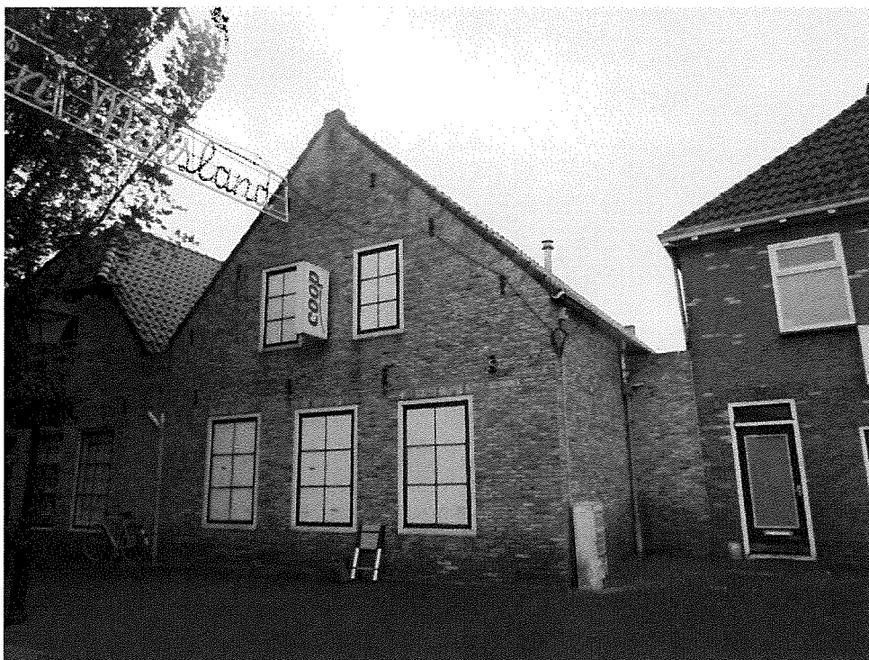
1. Voorgevel van Oosterburen 4.
