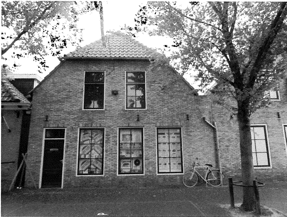
3. Voorgevel van Oosterburen 6.
