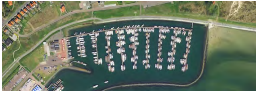
Het stapelsysteem van de passantenhaven is gedateerd, onvriendelijke en brandgevaarlijk
