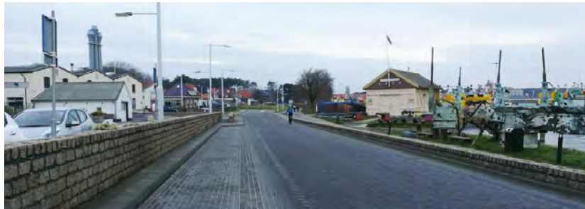
Waterkerende muur (links) Willem Barentszkade. Het lage muurtje rechts dient als golfbreker bij een overstromingssituatie
