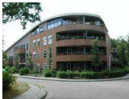
Appartementencomplex De Boeg in West- Terschelling
