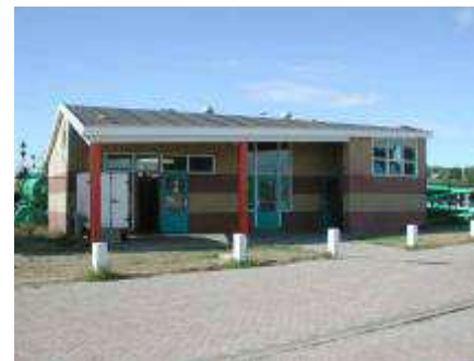
Individueel gebouw in het havengebied.
