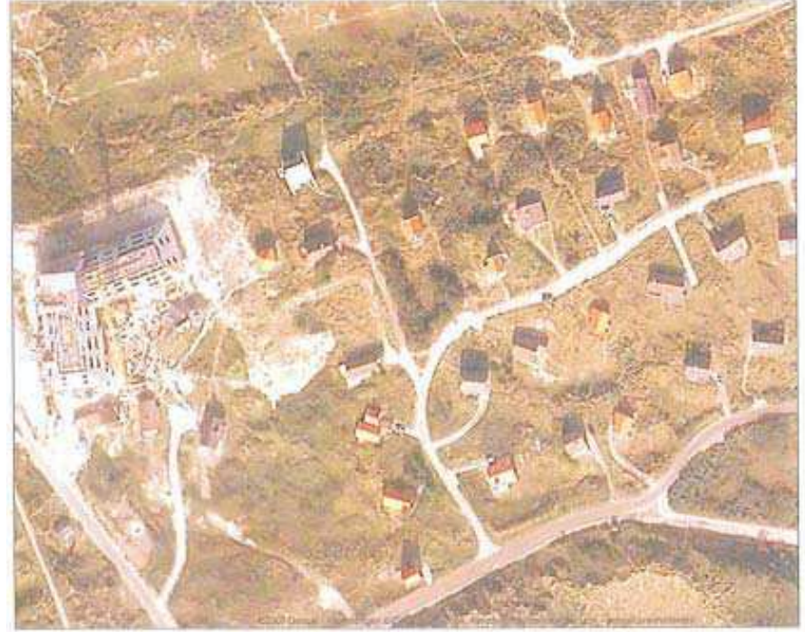
West aan Zee Detail westelijk deel
