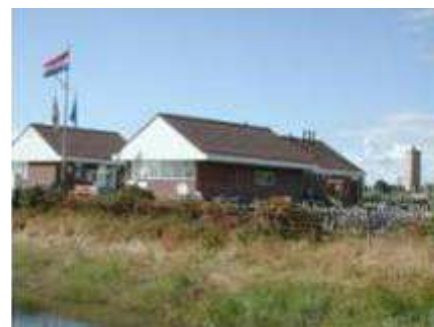
Toiletgebouwen bij de jachthaven.
