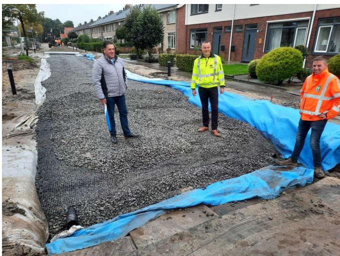
Waterbergende functie aangebracht. Begherstraat/Dunantstraat Vriezenveen
