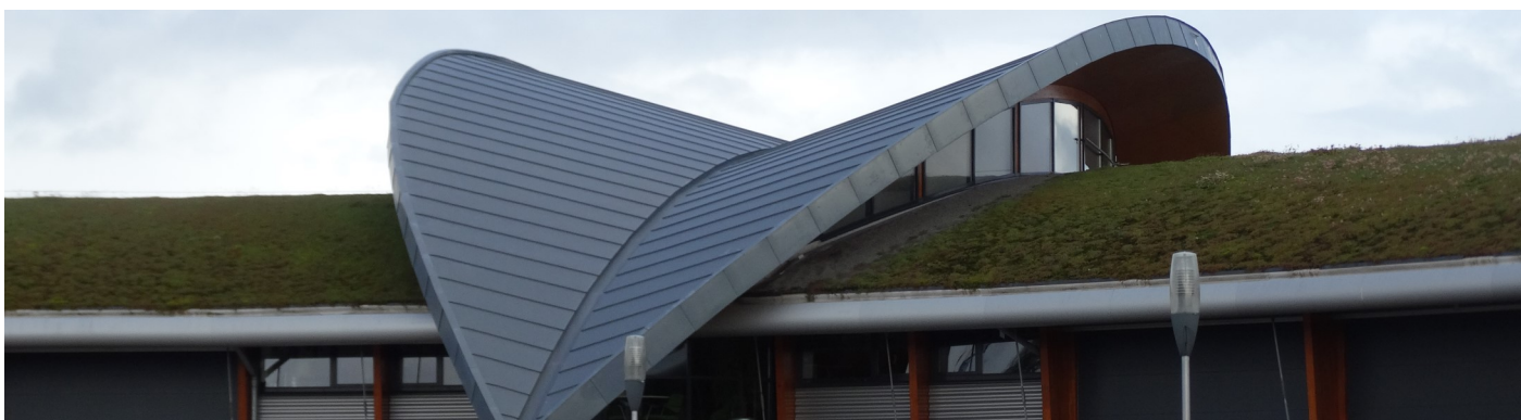
Sedumdak gemeentewerf Twenterand
