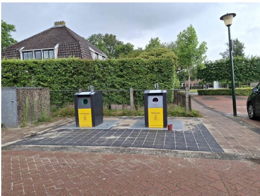
Figuur 1. Ondergrondse container blank en bont glas.
