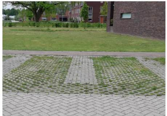
Figuur 14 Waterdoorlatende verharding parkeervakken
