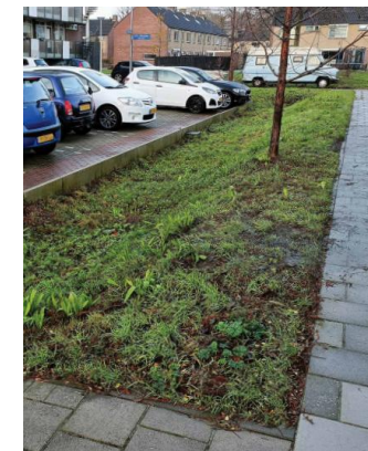
Voorbeeld van slimme inrichting van groenvoorzieningen om water zo lang mogelijk lokaal vast te houden
