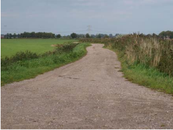
Onverharde weg langs 'Nieuwe Diep'
