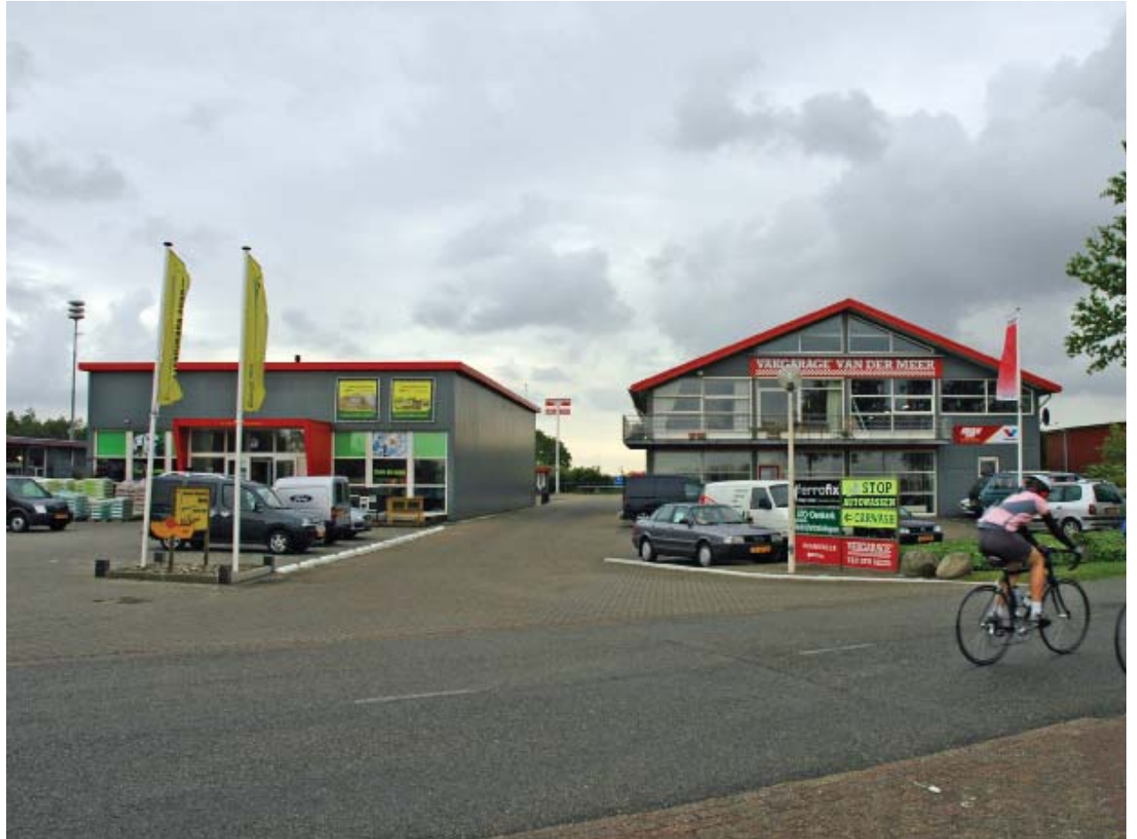
Bedrijventerrein R. van Nautaweg; rommelig entreegebied, dominante reclame en signaalkleuren
