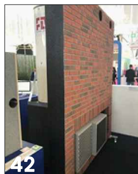
Buitenunit inpandig in gevel verwerkt
