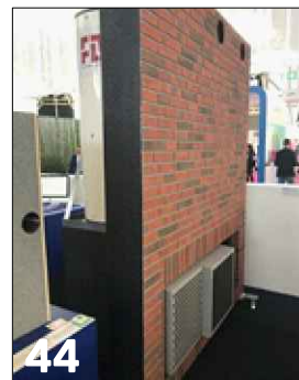
Buitenunit inpandig in gevel verwerkt
