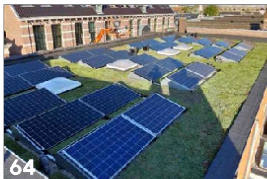
Extensief groen dak in combinatie met zonnepanelen
