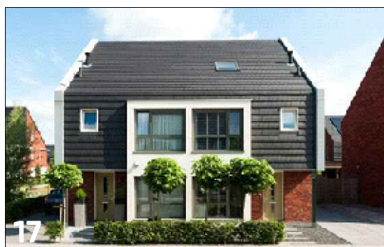
Twee-onder-een-kap met een langskap (mansardedak)
