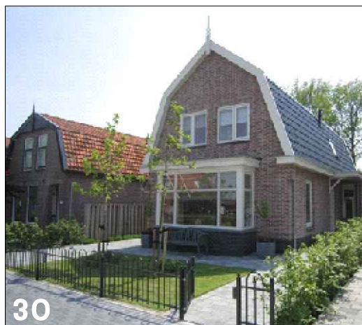
Vrijstaande woning met traditionele mansardedakvorm en toepassing van een makelaar in de nok
