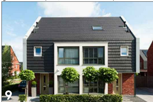
Vierkante gevelgeleding met toepassing van een verlaagde goot en divers materiaalgebruik
