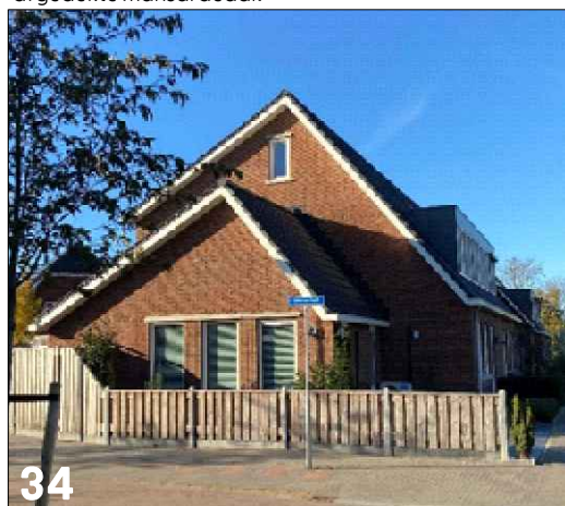
Toepassing van een dakopbouw met eenzelfde dakoriëntatie als hoofdgebouw
