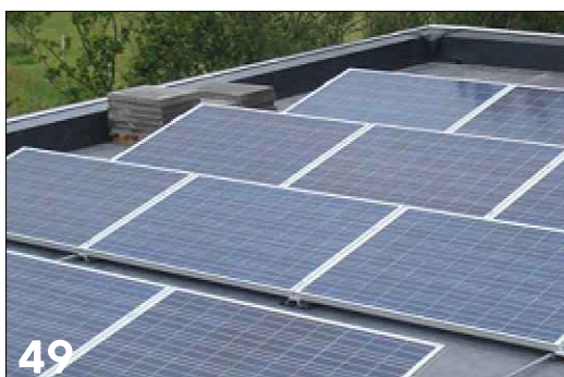
Zonnepanelen op plan dak met hogere dakrand/dakopstand
