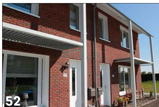
Toepassing van lamellen ten behoeve van schaduwwerking
