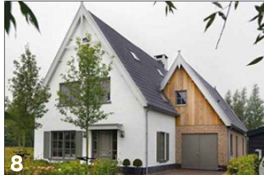
Vierkante gevelgeleding met toepassing van verschillend gevelmateriaal (stuc, hout en metselwerk)
