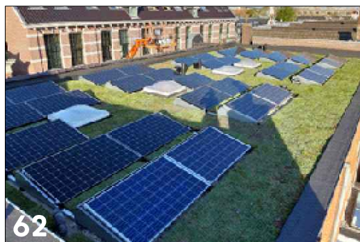
Extensief groen dak in combinatie met zonnepanelen
