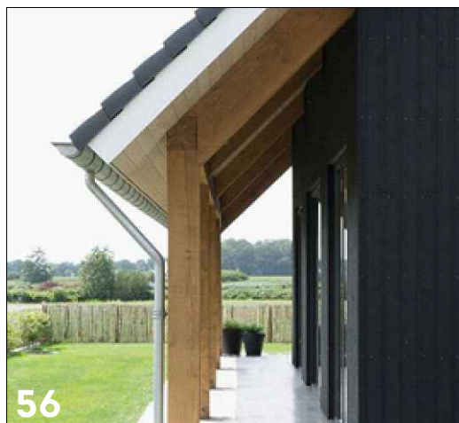
Dak overstek creëert schaduwwerking
