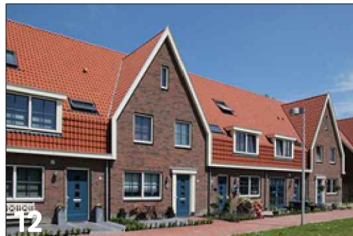
Vierkante gevelgeleding met toepassing van een verlaagde goot
