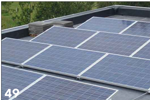
Zonnepanelen op plan dak met hogere dakrand/dakopstand
