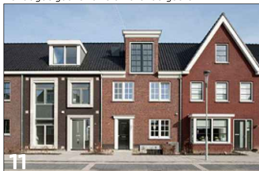
11 Vierkante gevelgeleding met toepassing van verschillende gevelcomposities
