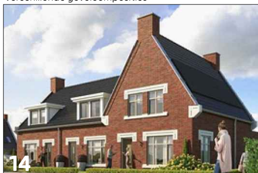
14 Accentuering van een vierkante gevelgeleding
