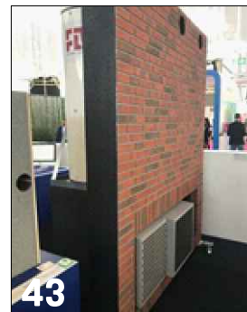
Buitenunit inpandig in gevel verwerkt
