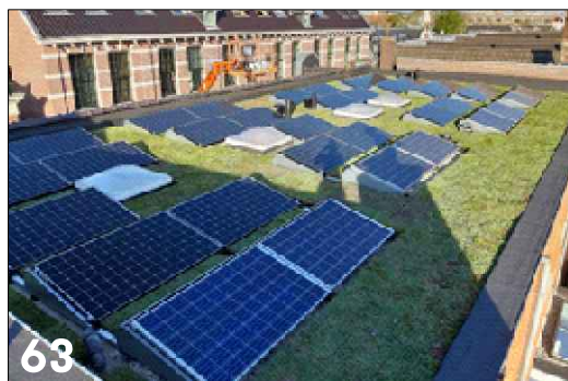
Extensief groen dak in combinatie met zonnepanelen
