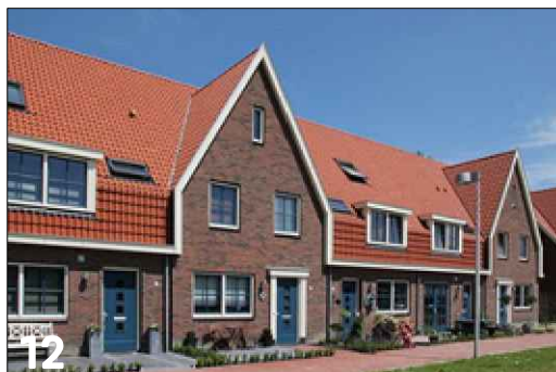
12 Vierkante gevelgeleding met toepassing van verschillende gevelcomposities
