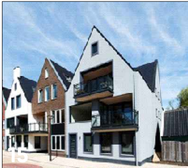
15 Ontsluiting van wooneenheden op begane grond aan voorzijde complex
