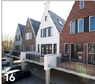
16 Ontsluiting van wooneenheden op verdieping aan achterzijde complex
