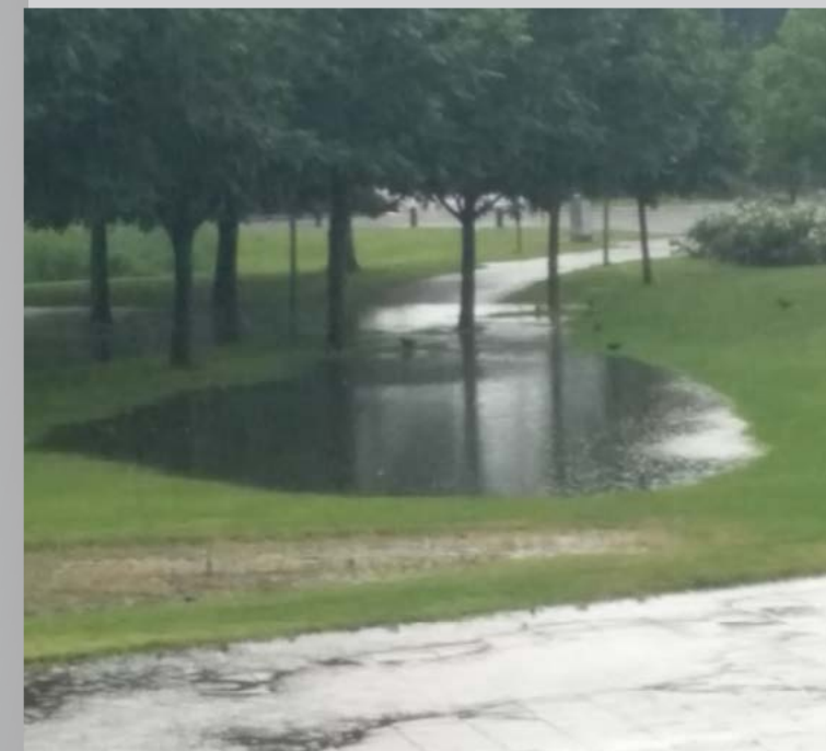
Figuur - berging in infiltratievoorziening
