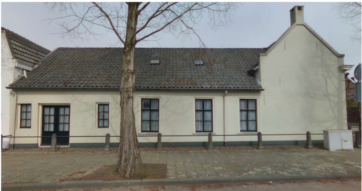
Voorgevel Dommelseweg 19A
