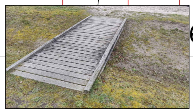
Bestaande houten brug
