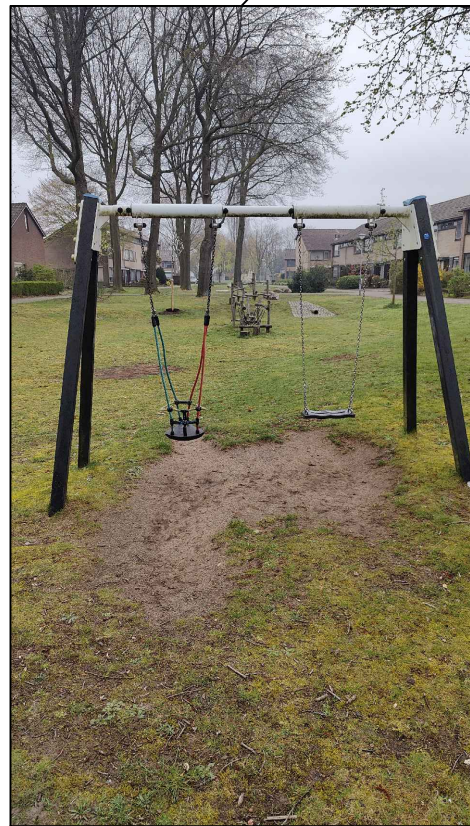
Bestaande schommel Grasversterkingsmatten aanbrengen
