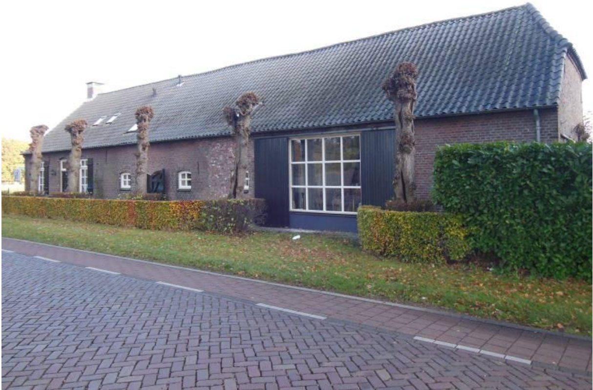
Langgevelboerderij uit 1908 onder zadeldak met wolfseind.
