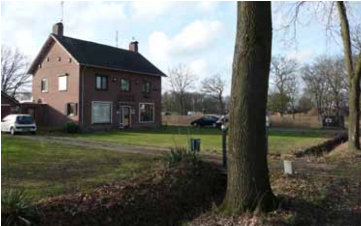
bestaande woning aan Venbergseweg
