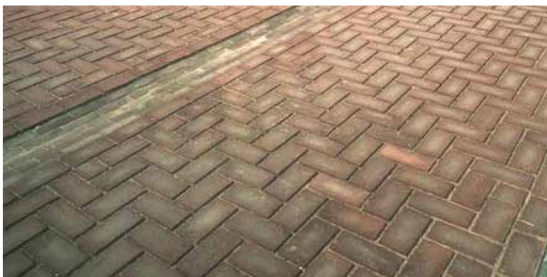
Loopgedeelte markeren door goot een afwijkend legpatroon
