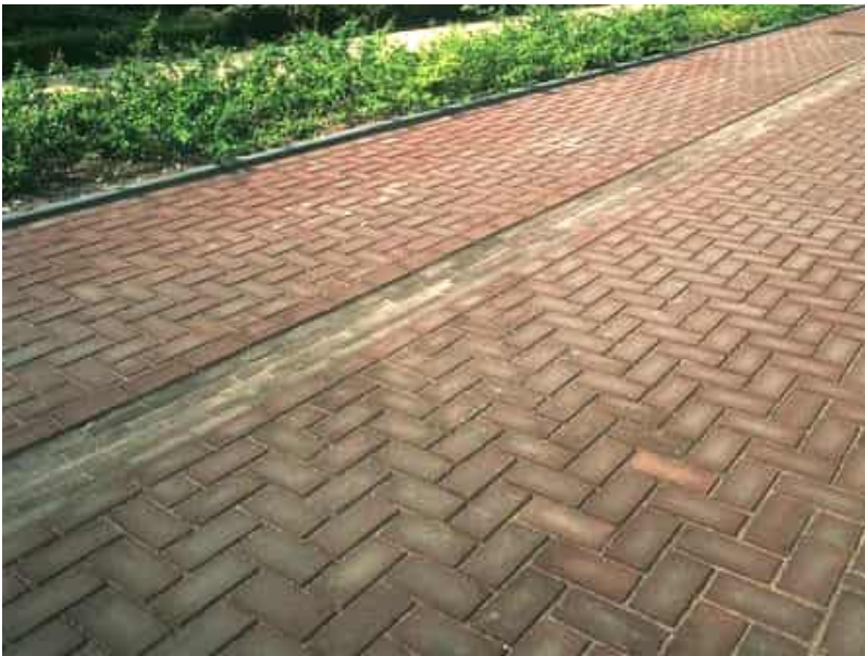
loopgedeelte markeren door goot (zie referentiefoto) en afwijkend legpatroon
