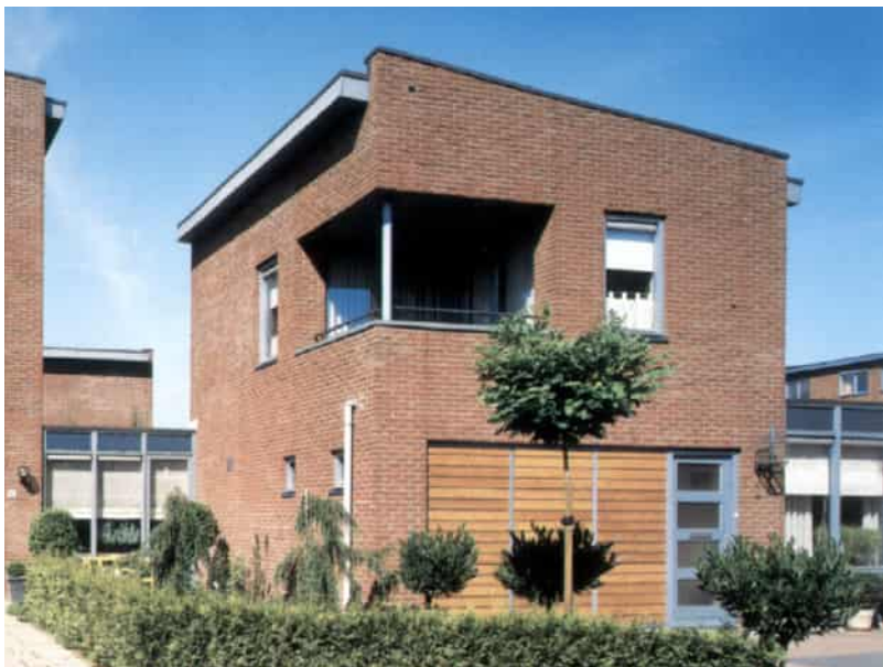
incident: een afwijkende bouwmassa
