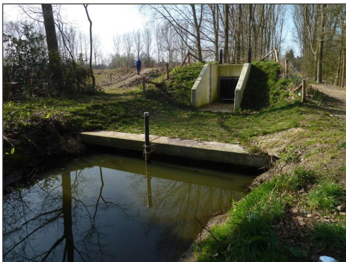
Foto: Uitstroom bergbezinkbassin Schrijnerwei
