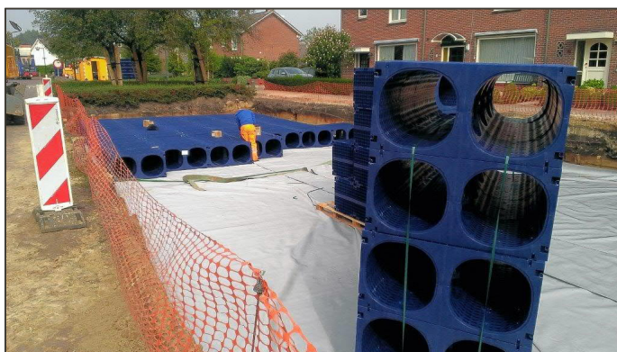
Foto: Aanleg berging middels kratten Hyacintenlaan
