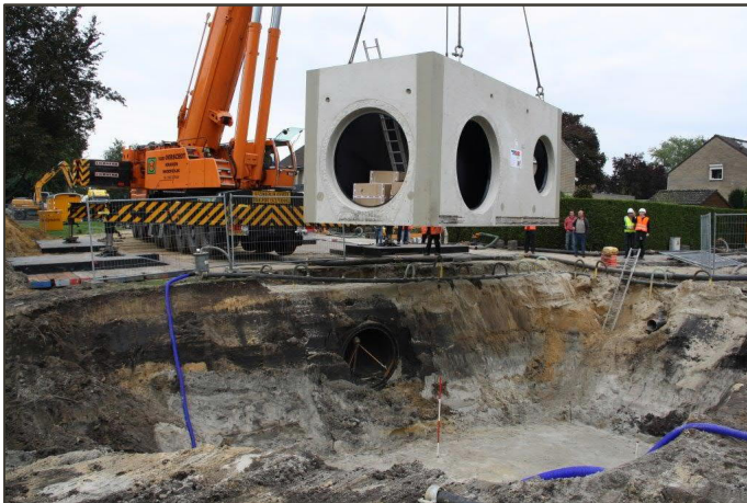
Foto: Rioleringswerk Kornoeljelaan – Lijsterbeslaan
