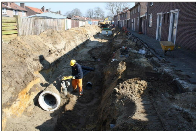
Foto: Rioolrenovatie Gelukken
