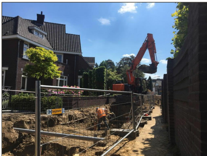
Foto: Riolervervanging Meerstraat
