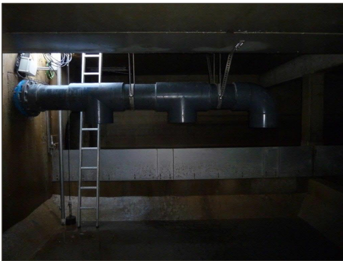
Foto: Spoelinstallatie bergbezinkbassin Kreijenbeek
