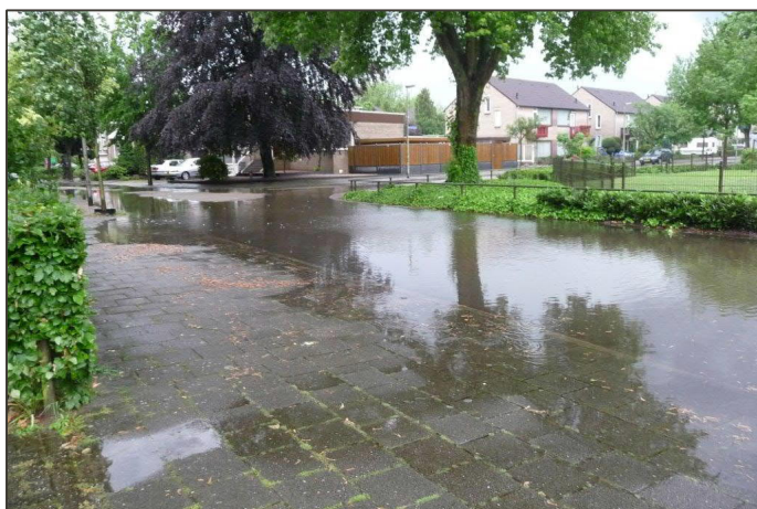
Foto: Water op straat na extreme neerslag Gaspeldoornlaan
